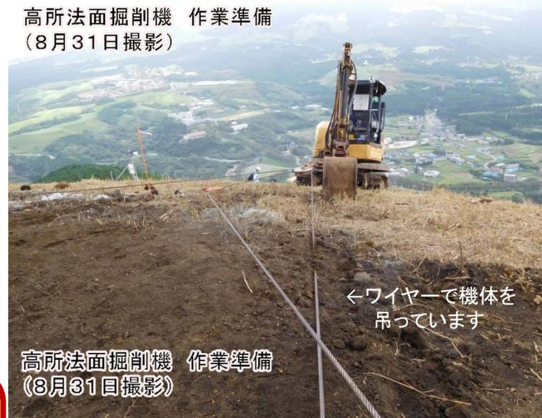
大規模工事のため、国内でも珍しいカメラ付き掘削機にて作業を実施
